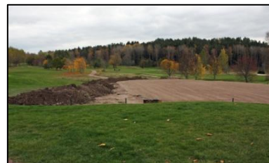
"Nya övningsgreenen" under ombyggnad" 17/10
