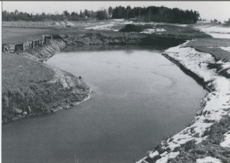
Det nya vattenhindret på 6:an börjar ta form.
