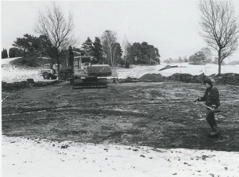
Här färdigställs grunden för nya greenen till hål 2
