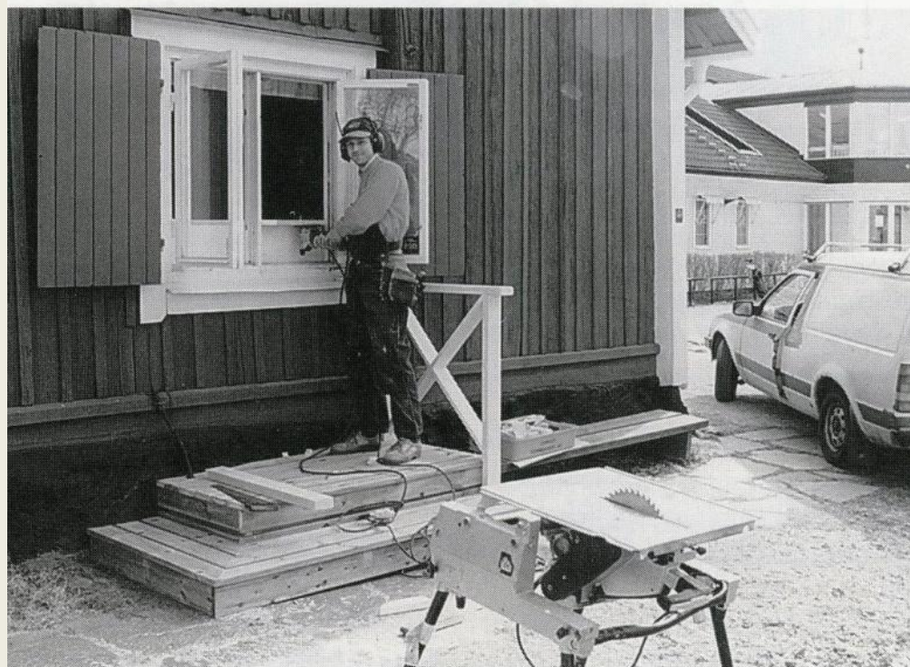
Snickaren Dennis Albertsson slutför arbetet med nya kiosken.
